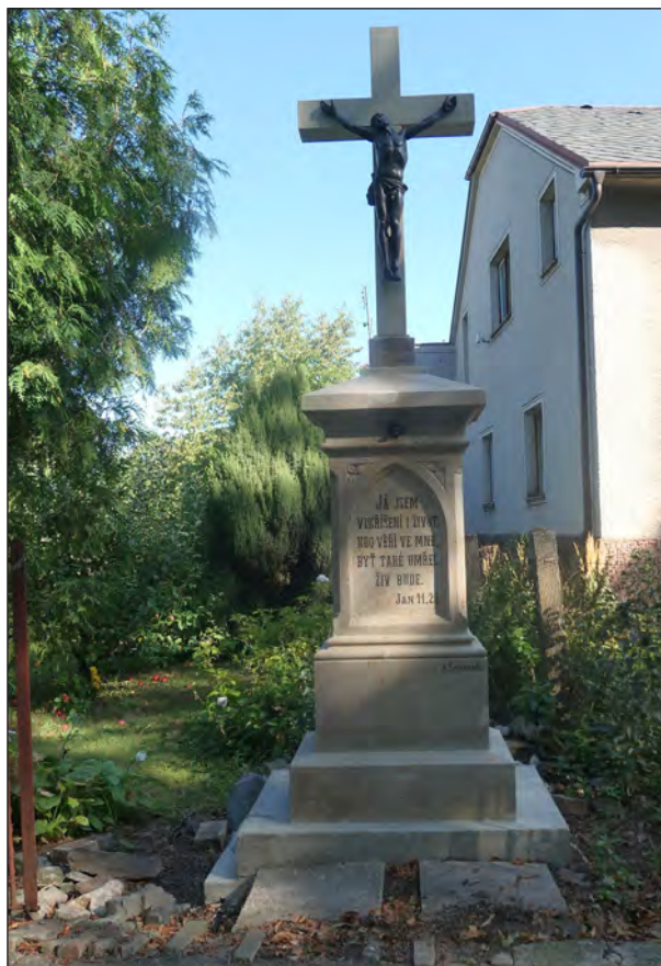
Kříž po opravě.
