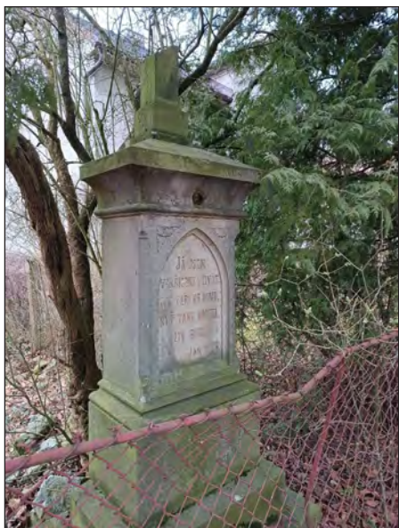
Kříž před opravou.
