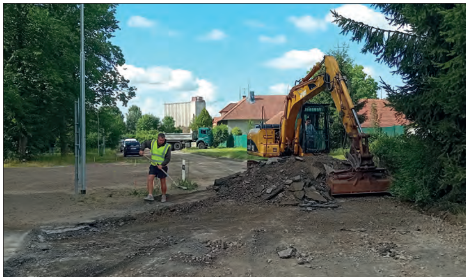
Druhá část stavby příjezdové silnice, chodníku a parkovacích míst ke gymnáziu, respektive ke sportovní hale Pulická je v plném produdu.
