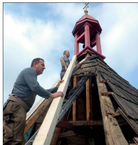
Oprava střechy a krovu kapličky v Domašíně
