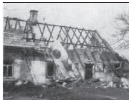
Celkový pohled na poškozený domek a pohled ze strany dopadu MiG-5SB.
