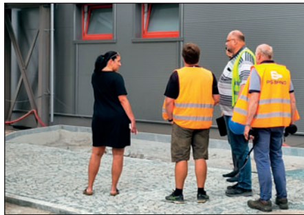
Snímek z kontrolního dne na stavbě nové sportovní haly.
